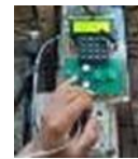
Gambar 14. Percobaan Alat Pada Pelanggan
