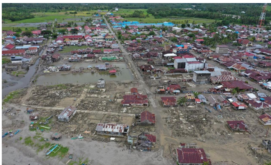
Gambar 6. Kondisi Permukiman Pasca Banjir Rob Di Desa Tompe
