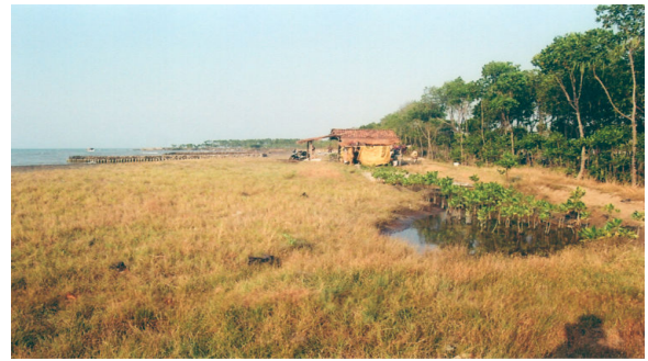
Gambar 17. Pantai Maribaya Tegal. Mangrove ditanam di dalam kolam galian yang dibuat di atas lahan berpasir dan tanpa sirkulasi ke laut. Pantai ini distabilkan dengan deretan groin.
