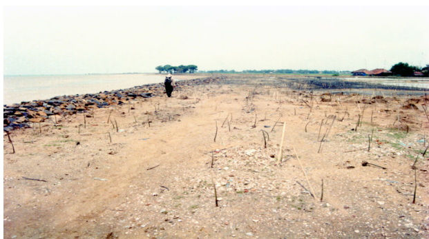
Gambar 14. Pantai Tanjungpura - Indramayu. Mangrove ditanam di atas timbunan pasir di sebelah belakang dinding pantai dari pasangan batu. Mangrove dalam keadaan mati.
