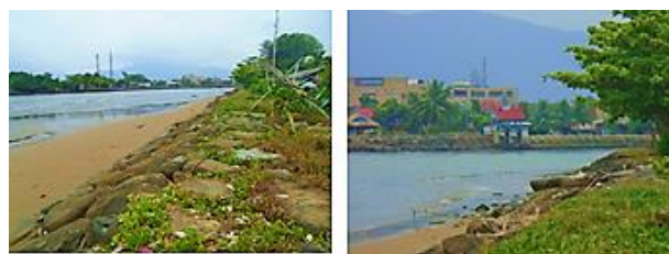
Gambar 5. Seawall di sisi Universitas Bung Hatta (kiri), dan jetties dan sea wall di sekitar Universitas Bung Hatta (kanan). (Dok. Peneliti)
