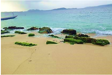
Gambar 7. Sisa fondasi bangunan perumahan penduduk yang rusak akibat abrasi di Pantai Jati. Lumut yang tebal menunjukkan kerobohan akibat abrasi sudah terjadi cukup lama. (Dok. Peneliti)
