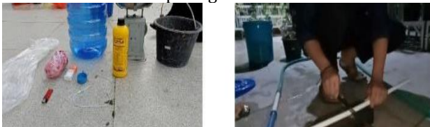
Gambar 2 Penyiapan alat dan pemotongan pipa untuk pemasangan alat
