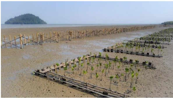
Gambar 15. Breakwater dan Mud Trap di MMP Tahun 2023
