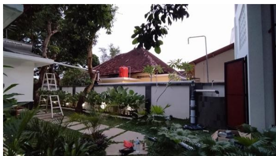
Gambar 7. Pemasangan Alat Injeksi Air Hujan dengan Tipe Bangunan Atap
