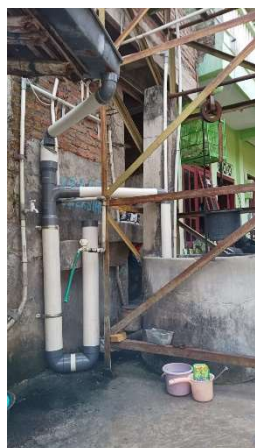
Gambar 5.6 Pemasangan Alat Injeksi Air Hujan di 2 Lokasi Perumahan Code Kelurahan Terban
