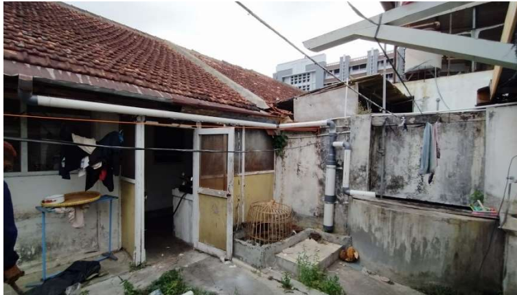
Gambar 5.5 Pemasangan Alat Injeksi Air Hujan dengan Tipe Bangunan Atap Tinggi di Permukiman UGM dengan (A) Rumah Dekan FEB, (B) Rumah Dekan FH, dan (C) Sekretariat UKM UKJGS
