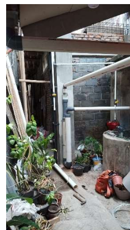
Gambar 5.6 Pemasangan Alat Injeksi Air Hujan di 2 Lokasi Perumahan Code Kelurahan Terban
