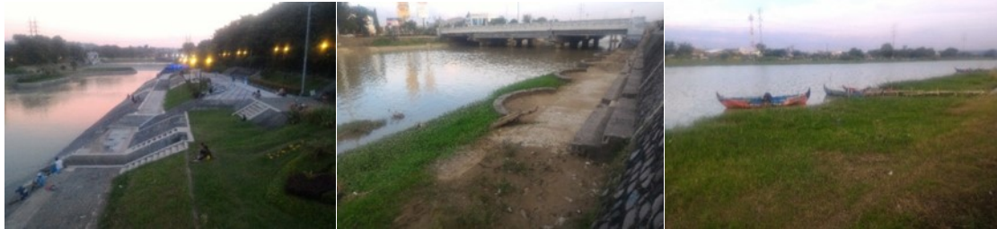
Gambar 2: Kondisi Existing Kawasan Banjir Kanal Barat
