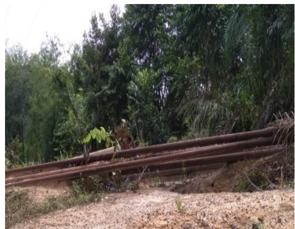
Gambar 10. Pipa Penyaluran Minyak .
