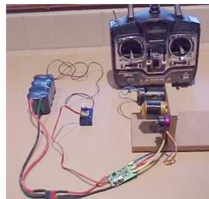
Gambar 15. Uji Fungsi Kendali Jarak Jauh Kombinasi Motor Battery
