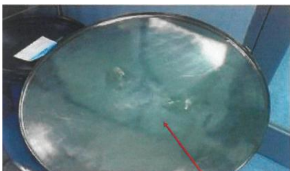
Gambar 7. Permukaan tutup atas S/S Holding Tank
