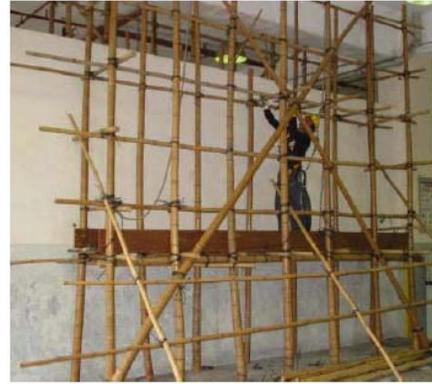
Gambar 7. Bambu untuk scaffolding (Chu, 2002).
