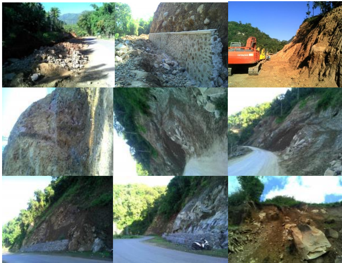
Gambar 18. Pengerjaan lereng longsor pada ruas Jalan Ende sampai Detusoko
