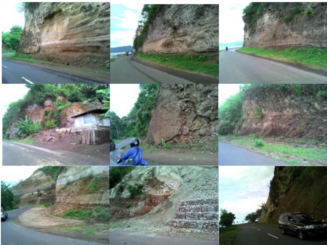
Gambar 15. Pengeprasan lereng dengan excavator
