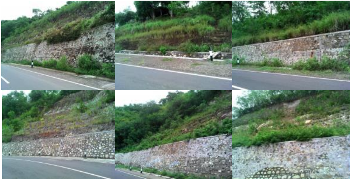
Gambar 16. Perkuatan lereng dengan pemasangan batu dan rumput vetiver
