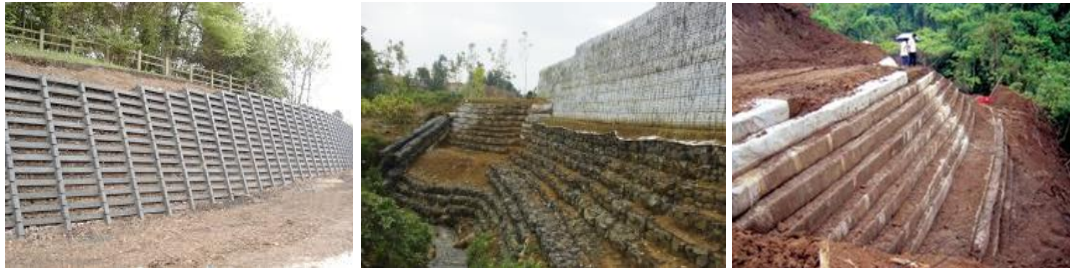
Gambar 11. Penanganan lereng dengan bahan geotextile (geoframe.geoforce-indonesia)
