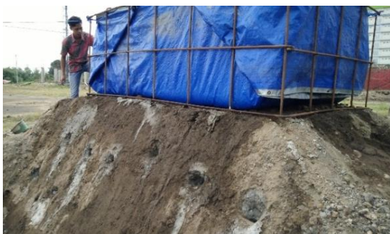
Gambar 7. Pembebanan dengan tumpukan air di atas timbunan tanah yang telah dilakukan injeksi.
