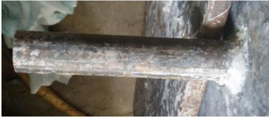
Gambar 6. Belum terjadi kebengkokan pada shear connector diameter 22 mm dengan panjang 110 mm
