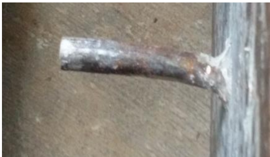
Gambar 4. Contoh kegagalan struktur, terjadi kebengkokan pada shear connector diameter 10 mm dengan panjang 50 mm
