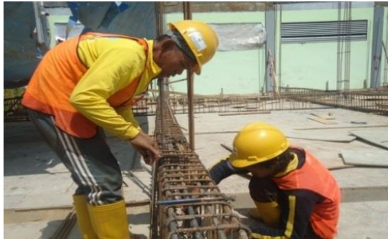
Gambar 2. Contoh pengamatan unjuk kerja tukang besi beton
