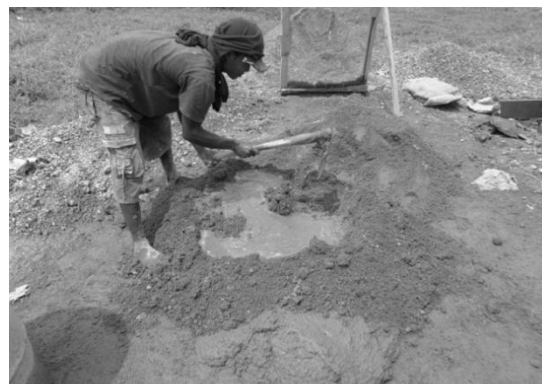
Gambar 13. Pengadukan beton secara manual oleh pekerja
