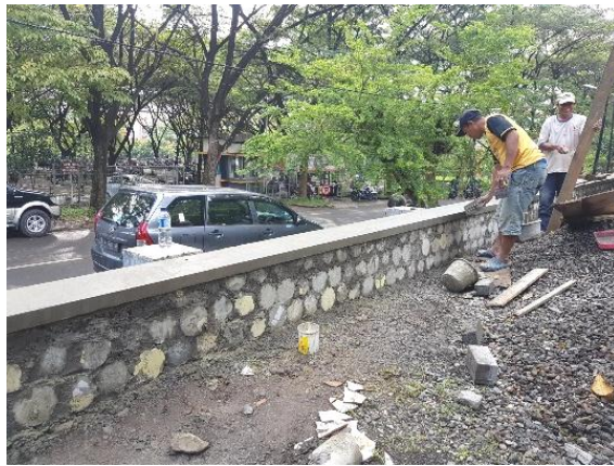
(a). Pekerjaan pembuatan retaining wall
