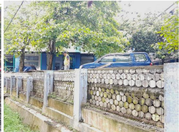
(b). Retaining wall dengan menggunakan limbah silinder beton
