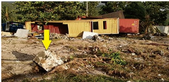
Gambar 3. Debris berupa pecahan tembok laut yang terseret ke daratan oleh tsunami di Selat Sunda 2018
