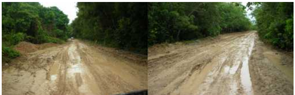
Gambar 1. Sub grade jalan berupa tanah lempung lunak ( soft clay ) yang tergenang air.
