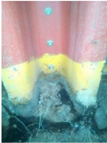
Gambar 3. Pemasangan pengaku bersip pada pondasi silo.
