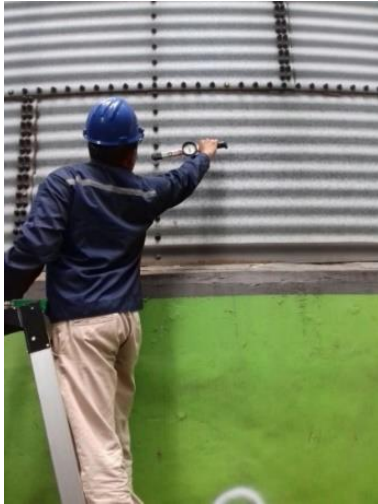
Gambar 6. Pengukuran torsi pengencangan baut pengikat dinding dan stiffner.
