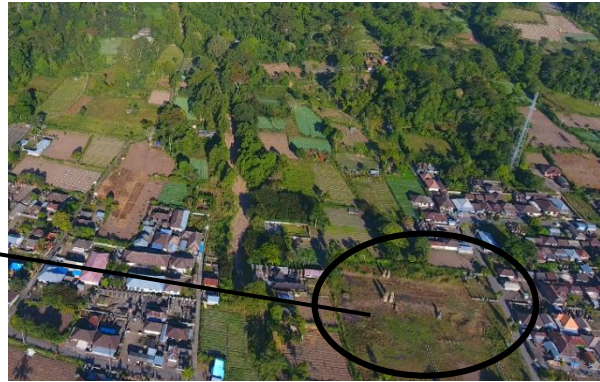
Gambar 4. Penampakan timbunan longsor
