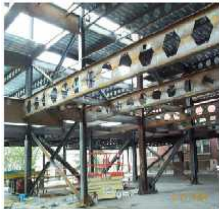
Gambar 1. Penggunaan Balok Kastela pada bangunan Parkir
