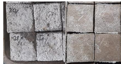
Gambar 14. Efflorescence pada mortar geopolimer
