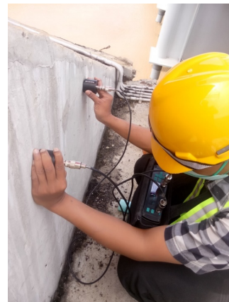
Gambar 4. Pemeriksaan kepadatan beton dengan alat Ultrasonic Pulse Velocity (UPV)
