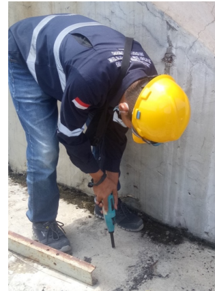
Gambar 3. Pemetaan kekuatan beton dengan alat Hammer test
