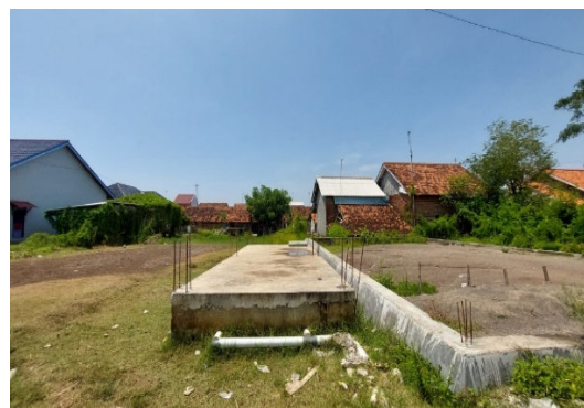
Gambar 10. Ground tank pemanenan hujan di Desa Sawojajar
