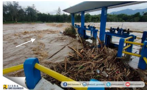
Gambar 3. Kondisi luapan dan sampah di bagian pintu pembilas
