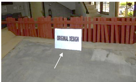
Gambar 2. Pembendungan menggunakan trashrack untuk pengkondisian muka air hilir
