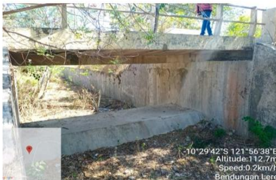
Gambar 7. Spillway Bendungan Lere
