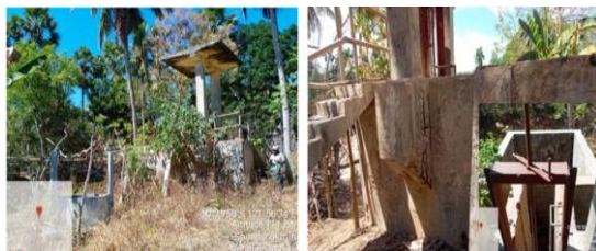
Gambar 8. Bangunan outlet Bendungan Lere
