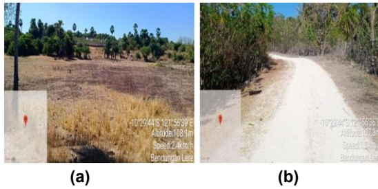
Gambar 6. Foto dokumentasi monitoring visual Bendungan Lere
