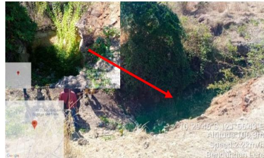
Gambar 3. Sinkhole pada daerah tampungan Bendungan Lere
