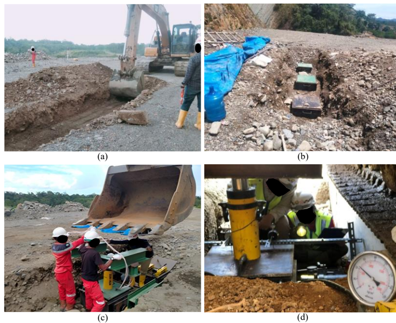
Gambar 11. Persiapan pengujian: (a) penggalian lubang uji, (b) pemasangan boks geser, (c) instalasi balok reaksi vertikal, dan (d) pemeriksaan sensor pergerakan dan sistem hidrolik
