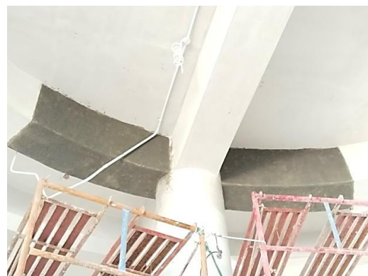
Gambar 9. Aplikasi perkuatan balok dengan FRP pada lokasi proyek
