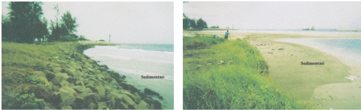
Gambar 4. Kondisi sedimentasi di alur masuk Pelabuhan Pulau Baai
