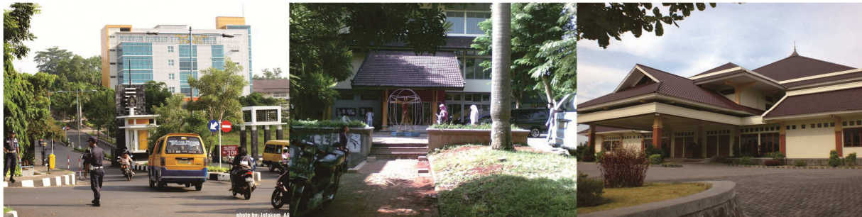
Gambar 8. Elemen-elemen yang paling banyak dikenali oleh pengamat: Gedung ICT [atas] Gedung Jurusan Arsitektur [tengah] Gedung Prof. Soedharto [bawah] Sumber: hasil analisis peneliti
