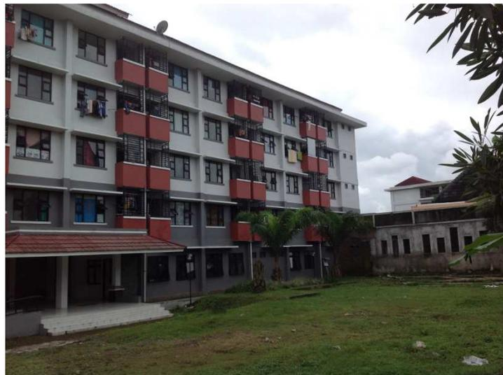
Gambar 8. Penggunaan elemen tritisan dan *sunshading* pada tampak bangunan
