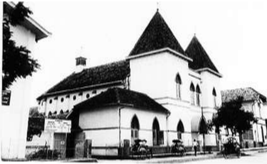
Gambar 2. Foto Bangunan Kapel Susteran Bangkang Semarang pada masa lalu (Sumber : Dokumentasi Jurusan Arsitektur FT Unika Soegijapranata)
