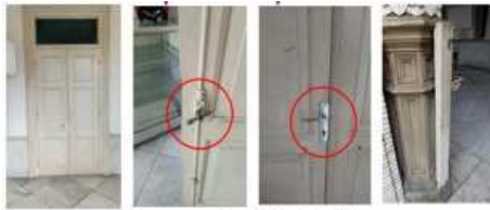
Gambar 7.20 Foto Detail Pintu Sumber : dok. Penulis
