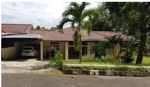
Gambar 8. Tampak depan Rumah Dinas Blok E 12.
