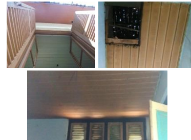
Gambar 25. Plafond Panel Kayu pada
