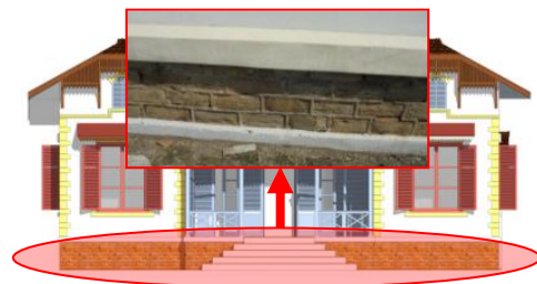
Gambar 12. Penebalan dinding dan pasangan batu bata
