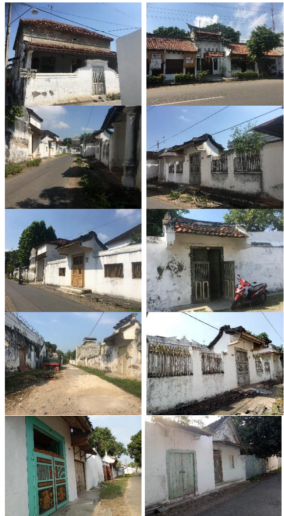
Gambar 37. Bangunan dan lingkungan permukiman Tionghoa di Kota Lasem (Foto Pribadi, 2017)
