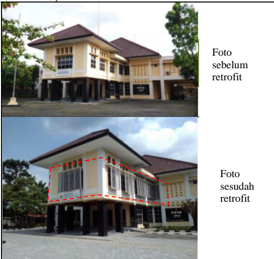
Gambar 3. Sebelum dan Sesudah Pemasangan Shading (dokumentasi PIP2B, 2018)
