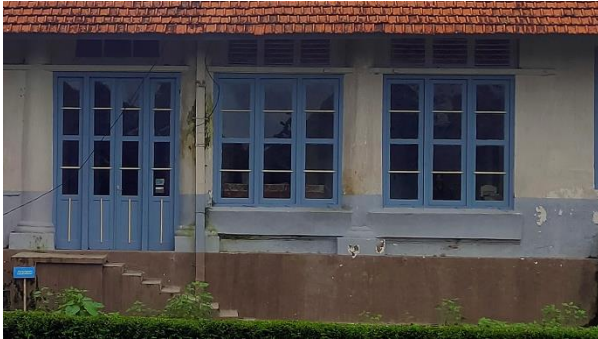
Gambar 7. Pintu di bagian samping kiri rumah mbesaran (Survey Lapangan, 2020)
