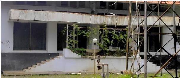
Gambar 8. Pintu di bagian samping kanan rumah mbesaran (Survey Lapangan, 2020)
