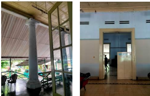
Gambar 9. Struktur Kayu sebagai penyangga atap dan kusen pintu (Survey Lapangan, 2020)
