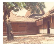
Dalem Pawon dan Sisir Pada Rumah di Langgar Dalem
