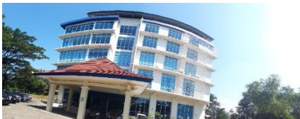
Gambar 5 Ruang Aset Dekanat FT Undip
