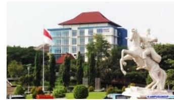
Gambar 2 Foto Tampak Depan Gedung Dekanat FT http://www.kampusundip.com/2016/04/finishing-pembangunan-dekanat-fakultas.html
