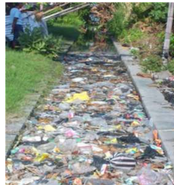
Gambar 2. Sampah yang Menyumbat Saluran Drainase
