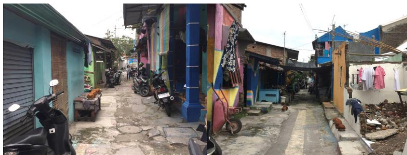
Gambar 6. Kondisi Jaringan Jalan Kampung Potrojayan
