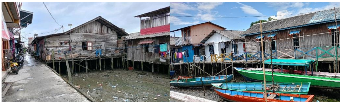
Gambar 3. Kondisi Eksisting Tipologi Kampung Atas Air
