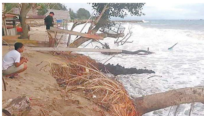
Gambar 2. Kondisi Abrasi Pantai di Pidie Jaya
