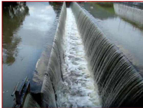
**Gambar 2.** Gambar dokumentasi pelimpahan/surplus air pada *spillway* Kolam pasir (Sumber: PLN)
