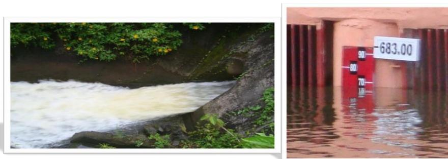
**Gambar 1.** Gambar dokumentasi pelimpahan/surplus air pada *spillway* kolam tando (Sumber: PLN)
