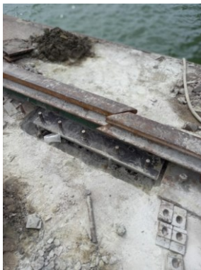
Gambar 8. Pergeseran pada sambungan jalur rel traveling wheels
