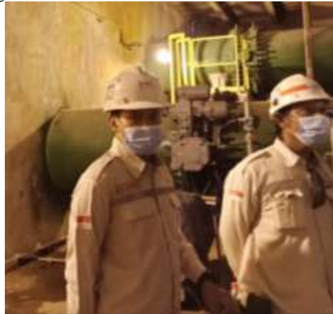
Gambar 1. Penggunaan helm di proyek
